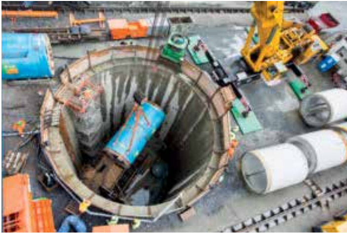
Eintransport der Tunnelbohrmaschine Foto: Rupert Oberhäuser/EGLV
